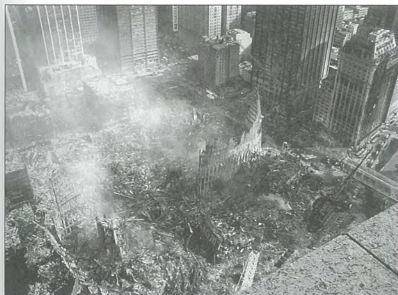
Коллапс зданий ВТЦ. До этого не было ни одного случая полного разрушения небоскребов, вызванного пожаром или какими-либо другими локальными повреждениями
