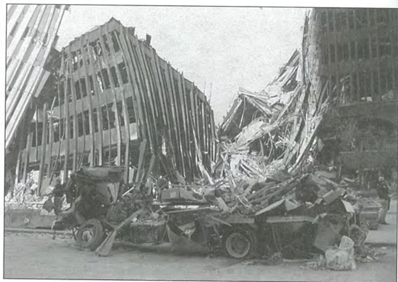
Разрушения на месте ВТЦ
