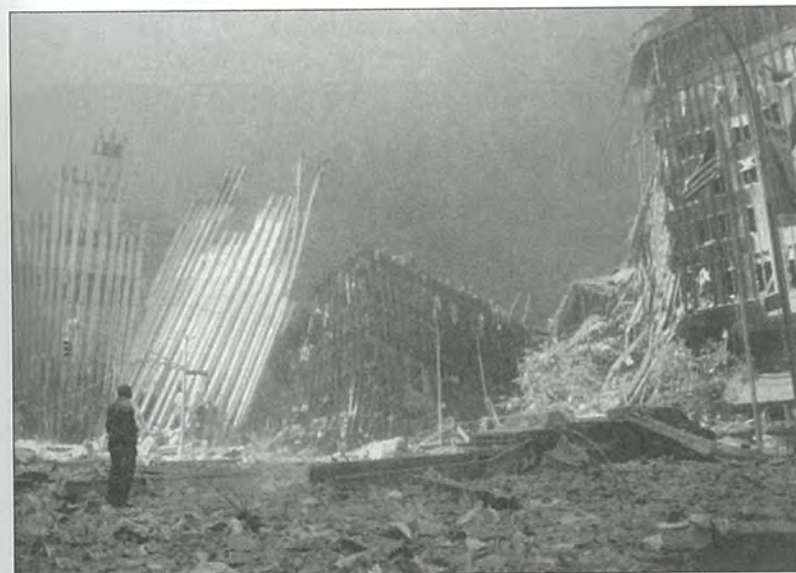
Вследствие тотальных обрушений башен-близнецов ВТЦ все остальные здания, находившиеся в непосредственной близости, были также сильно разрушены
