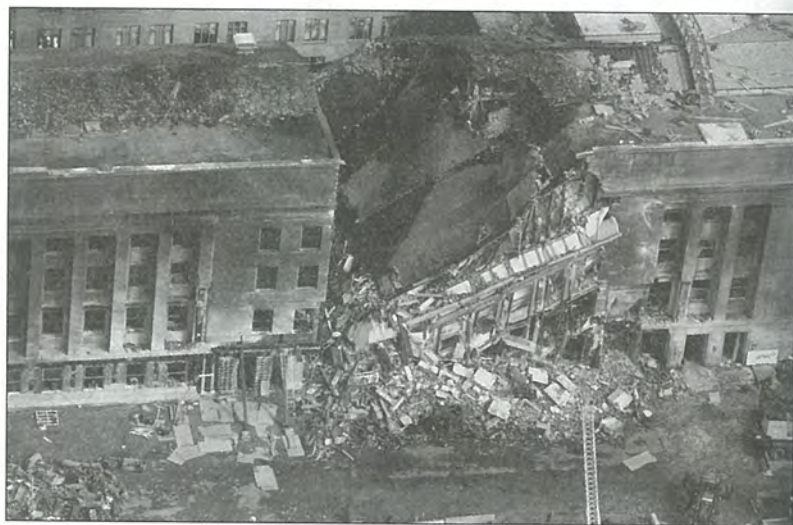
Вид здания Пентагона с разрушениями, произведенными в результате теракта 11 сентября
