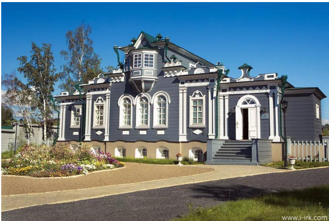
Дом-усадьба Трубецких после реставрации
