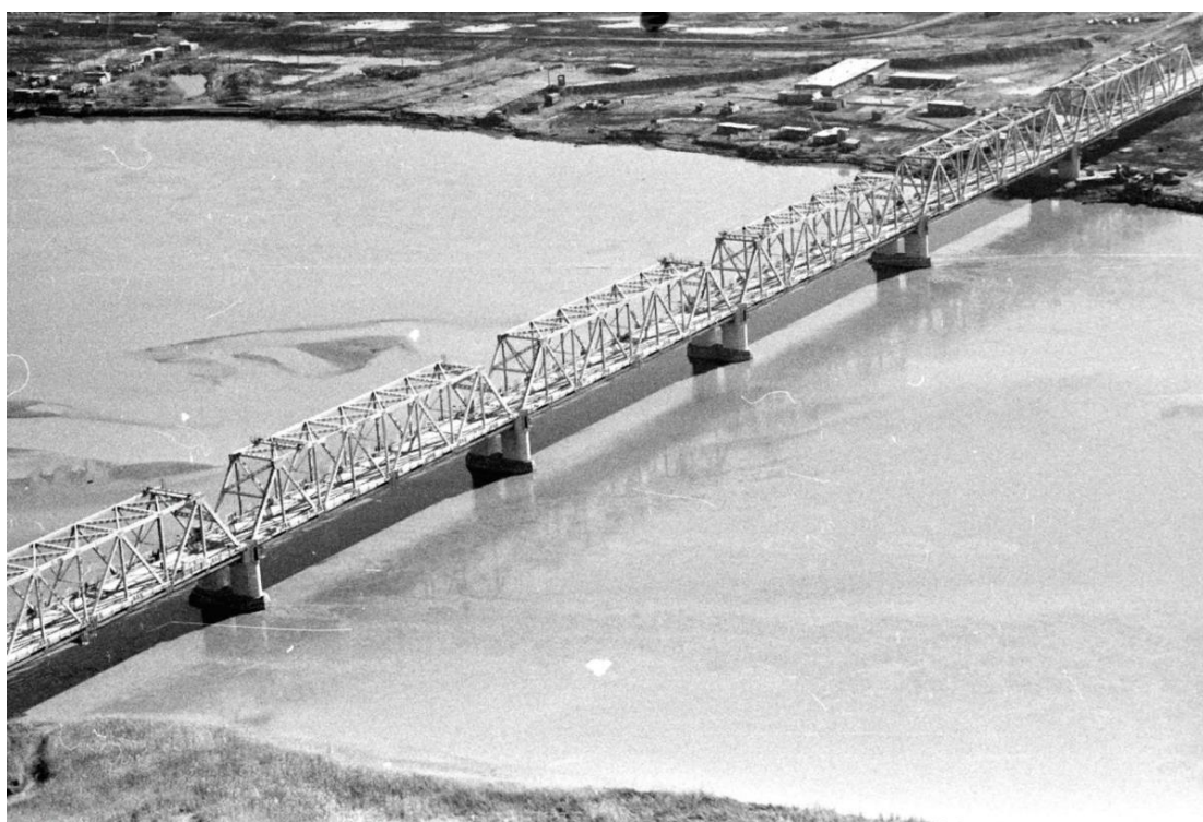
Мост дружбы из Термеза в Хайратон
