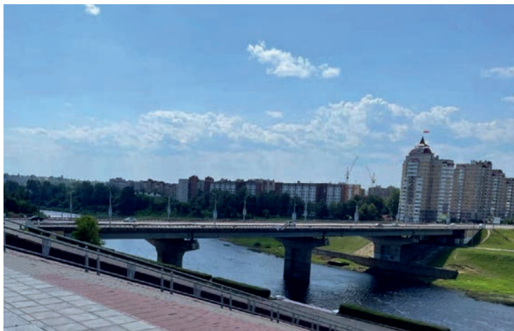
Мост Блохина в Витебске
